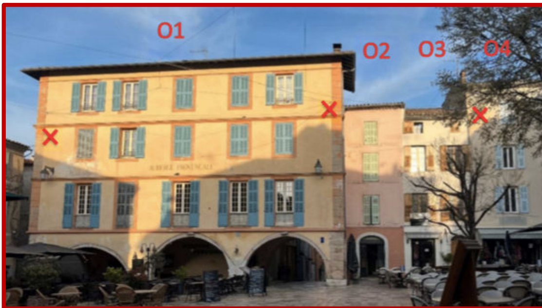
- Ancrages sur les façades Ouest -
