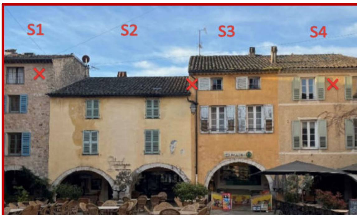
- Ancrages sur les façades Sud -
