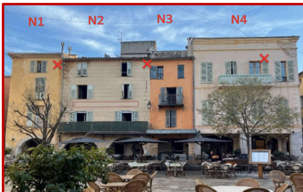
- Ancrages sur les façades au Nord de la place -
