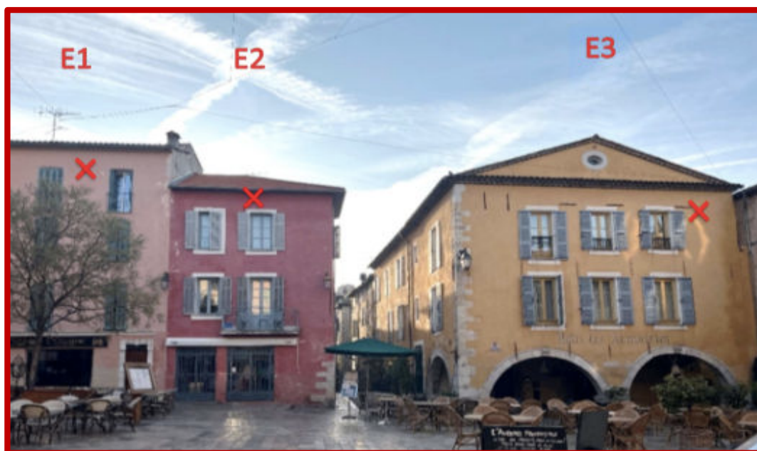
- Ancrages sur les façades Est -
